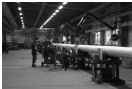
Rys. 1. Widok hali w której odbywa się spawanie rurociągu [8]
