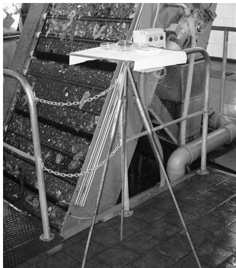
Rys.3. Pobieranie próbek metodą sedimentacyjną w budynku krat.
