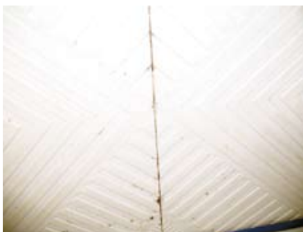
Rys. 5. Sufit łazienki wykonany styropianowymi płytami z widocznymi śladami grzyba na złączeniach płyt.
