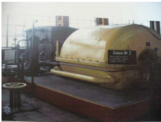
Rys. 2. Hala ssaw surowego gazu koksowniczego.
