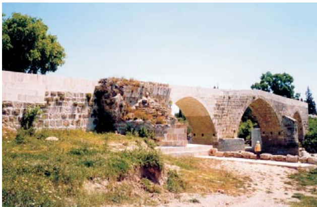
Ryc. 2. Współczesne i zabytkowe elementy trawertynowe mostu w Belkis (Turcja) Fig. 2. Modern and ancient travertine elements in construction of the bridge at Belkis (Turkey)
