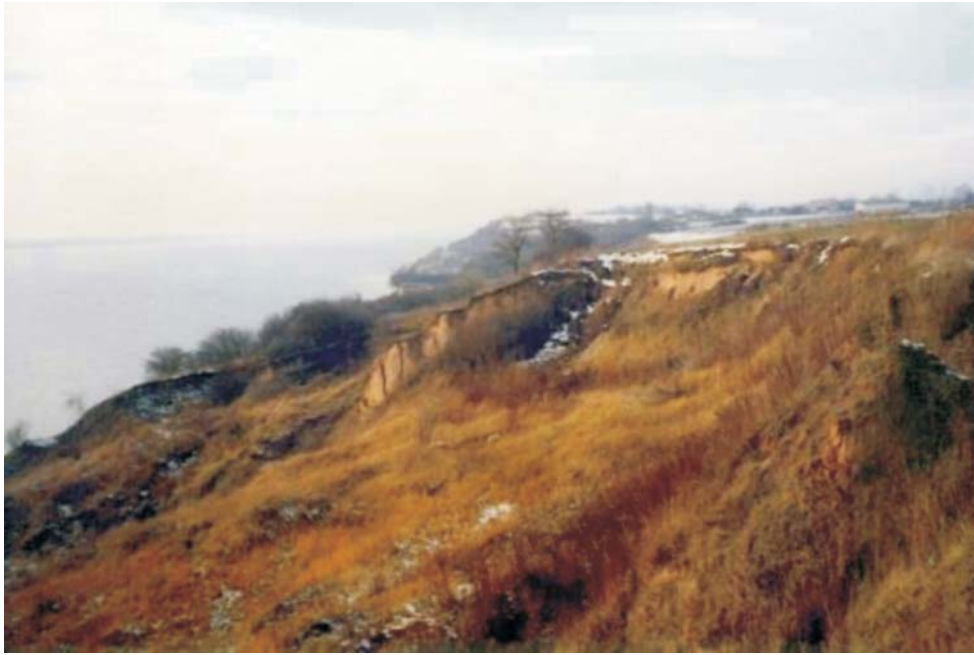
Fig. 5. Rumunki Zachodnie – the landslide in the bank of the Włocławek Artificial Lake (photo: A. Koryczan)
