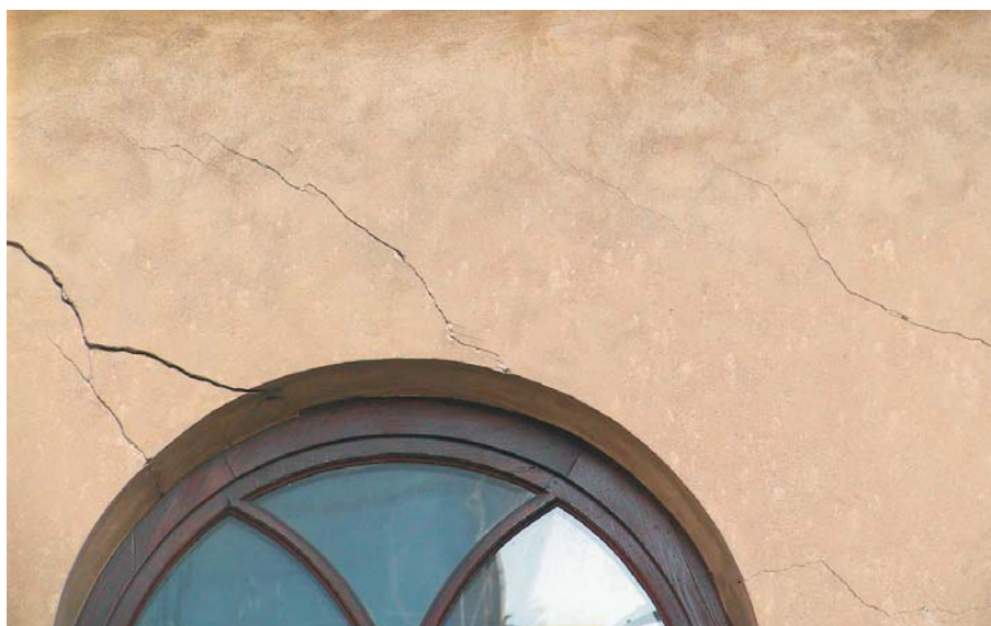
Ryc. 9. Przykłady spękanych budynków na terenie Wieliczki Fig. 9. Examples of distressed buildings in the Wieliczka area
