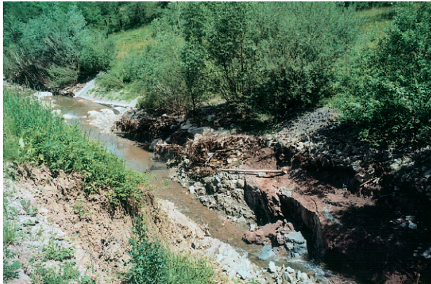
Fot. 6. Osuwisko w Bielance (powierzchnia poślizgu poniżej poziomu koryta potoku) aktywne i podcięte w czerwcu 2010 r.
