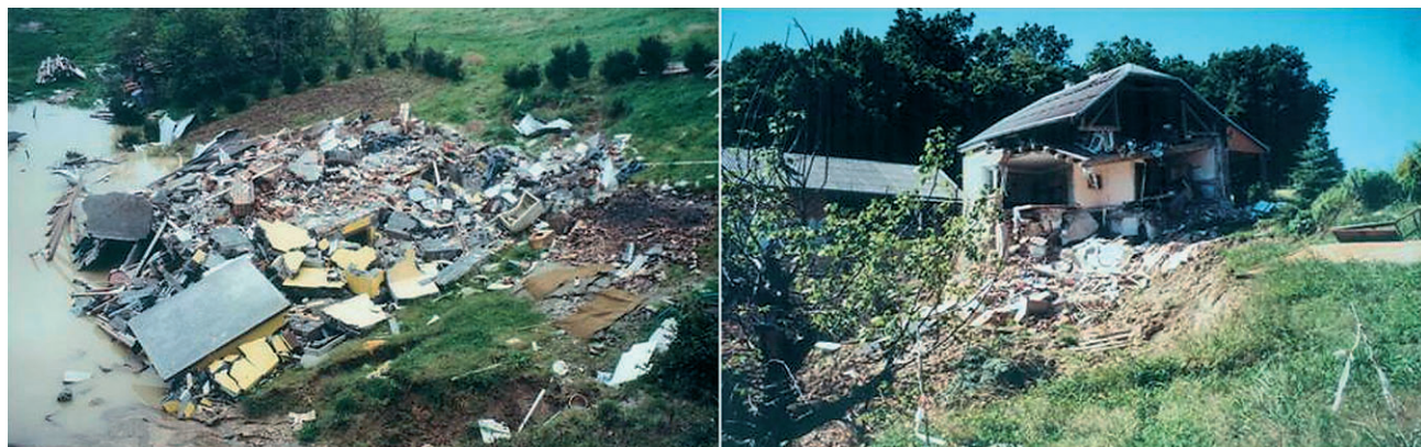
Fot. 5. Osuwiska na fliszu karpaccim powstałe po opadach w czerwcu 2010 r. w Kłodnem koło Limanowej (po lewej) i w Gorlicach (po prawej)
