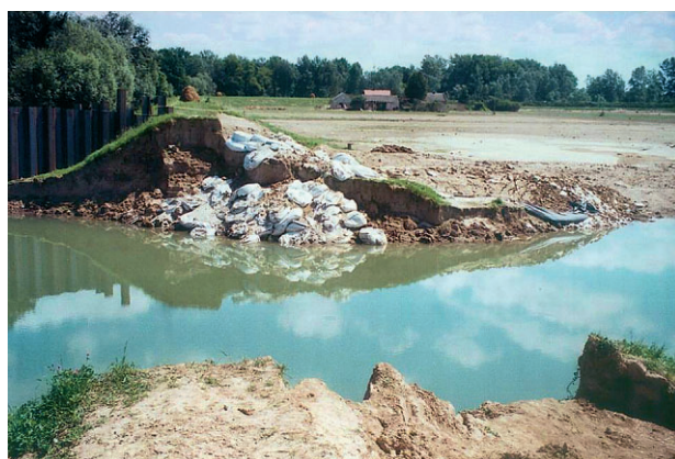
Fot. 8. Przekopany (w celu spłynięcia wód majowej powodzi), a następnie przerwany wał wisłany powyżej ujścia Brenia i rozległy stożek krewasowy (czerwiec 2010)
