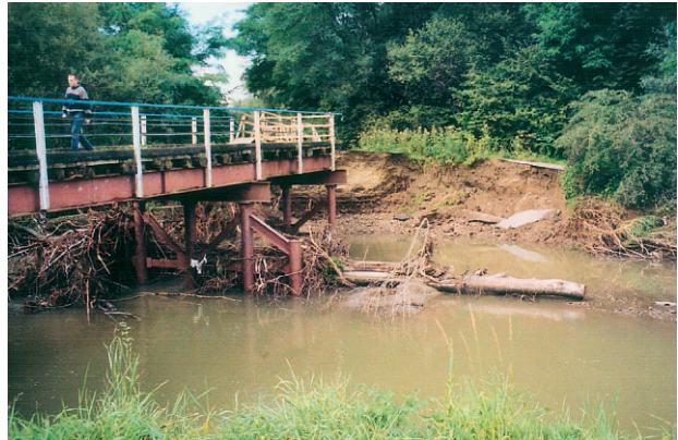
Fot. 7. Mostek na potoku Stradomka w Łapanowie zniszczony po raz trzeci w 2010 r. (wrzesień 2010)
