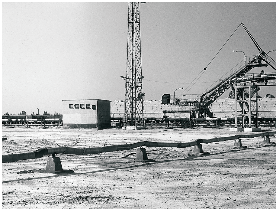
Fot. 1. Infrastruktura przemysłowa Kopalni Siarki „Siarkopol” w Grzybowie. Na drugim planie widoczne hałdy siarki (fot. A. Zieliński)
