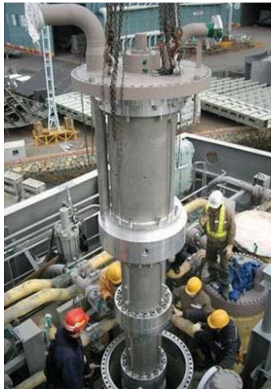
Rys. 6. Pompa ciśnieniowa podczas montażu [3] Fig. 6. Pressure pump during assembly [3]
