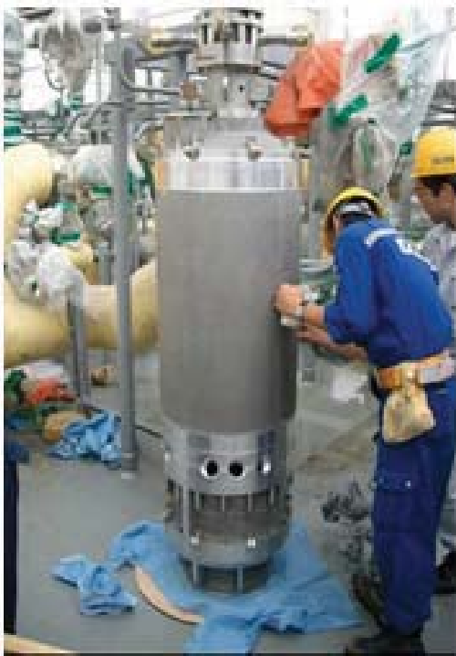
Rys. 4. Pompa zasilająca LNG podczas montażu [2] Fig. 4. Feed pump during assembly [2]
