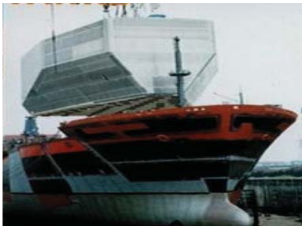
Rys. 3. Montaż zbiornika pryzmatycznego typu IHS na gazowcu LNG [źródło: Wikipedia] Fig. 3. The LNG carrier prismatic type tank during a assembly
