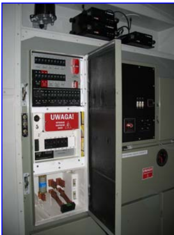
Rys.15. Widok na zmodernizowane szafy sterujące lokomotywy M62M
