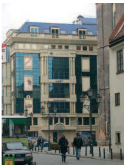
Fot. 4. Budynek Archicomu (fot. autorki)
