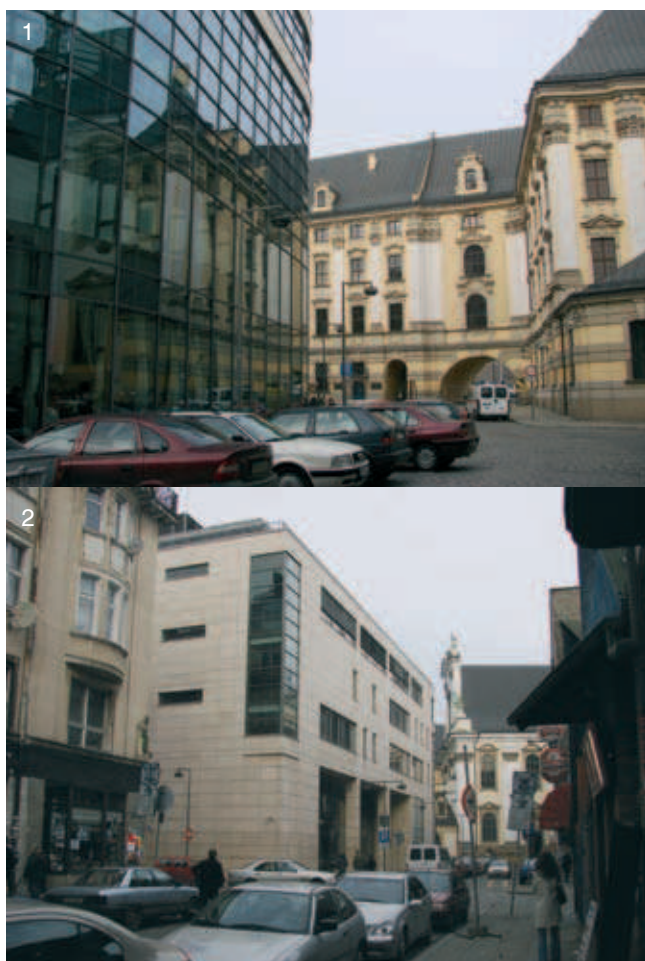
Fot. 1, 2. Budynek Wydziału Prawa, Administracji i Ekonomii we Wrocławiu (fot. autorki)
