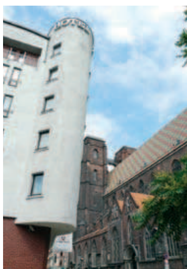
Fot. 12. Skrzyżowanie ulic Łaciarskiej i Kaznodziejskiej
