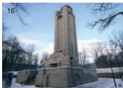
Fot. 14. Szyb windowy, stan po wykonaniu adaptacji (fot., projekt: autor, 2012 r.)
