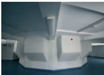
Fot. 9. Przestrzeń przeznaczona pod wynajem, stan po wykonaniu adaptacji (fot., projekt: autor, 2012 r.)
