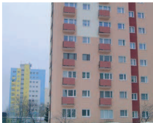
Rys. 1. Termomodernizacja zabudowy z wielkiej płyty w Poznaniu (fot. H. Zaniewska)
