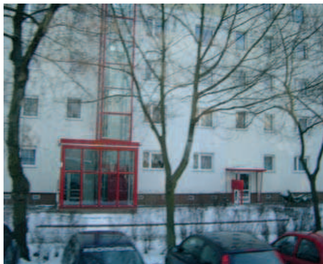
Ryc. 5 i 6. Przykłady renowacji budynków z wielkiej płyty, Weisswasser, Saksonia (fot. H. Zaniewska)
