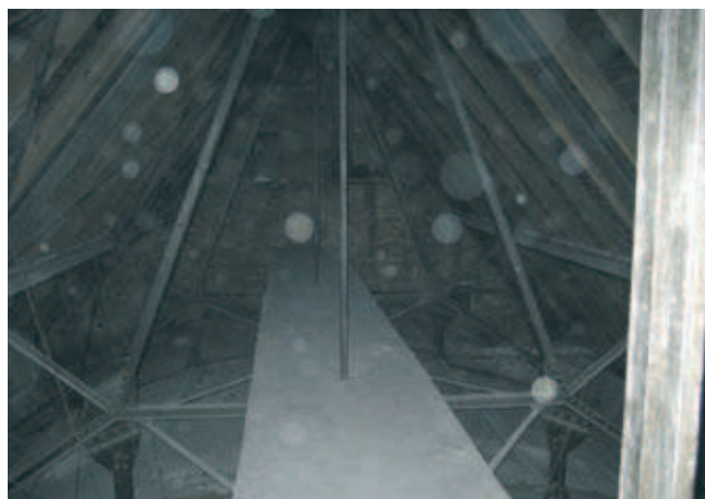
Rys. 7. Dźwigar dachowy Sali Lubrańskiego
