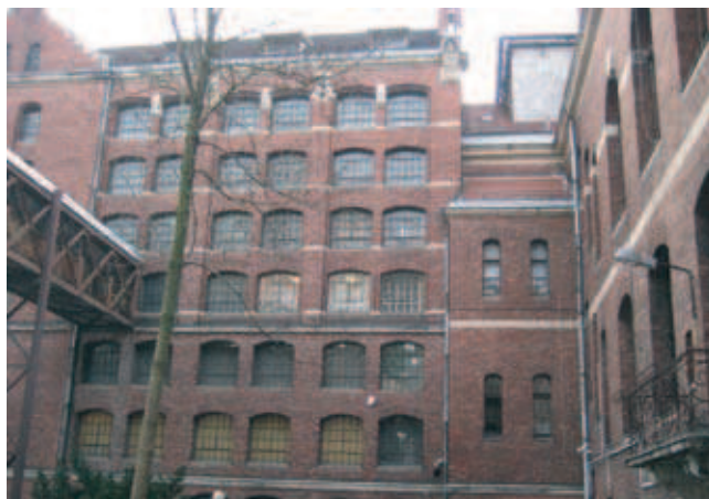
Rys. 5. Budynek magazynu biblioteki UAM
