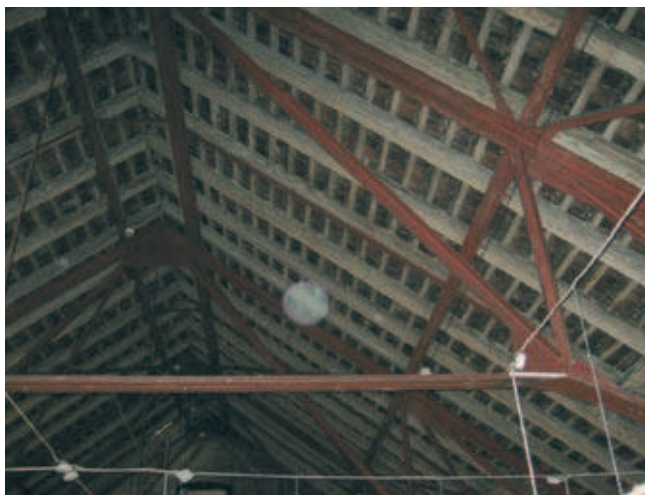
Rys. 12. Konstrukcja dachu nad Czytelnią Główną
