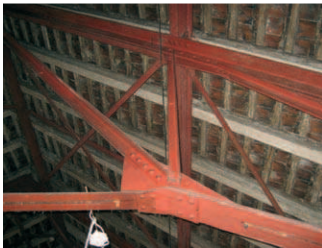
Rys. 13. Konstrukcja dachu magazynu książek
