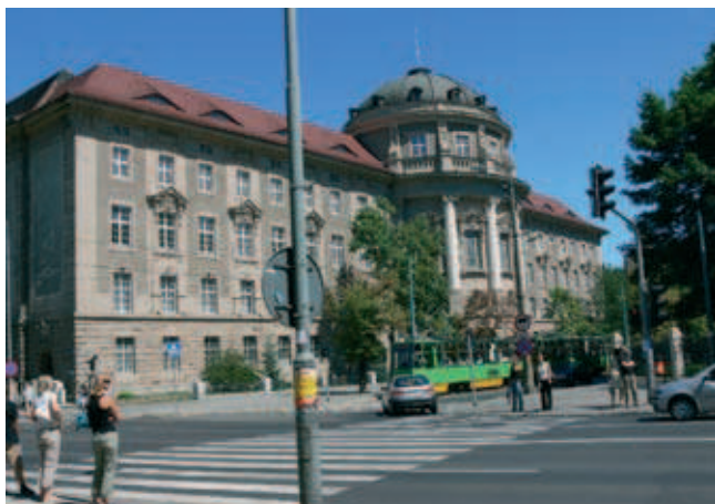
Rys. 3. Budynek Collegium Maius w Poznaniu od strony ul. Fredry
