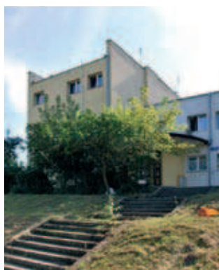
II. 2. Stacja Polskiego Radia (stan obecny)
