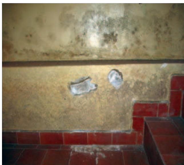
Fot. 3. Przykład pleśni i zasolenia (fot. W. Eckert, 2010)
