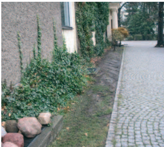
Fot. 4. Opaska gruntowa od strony południowo-wschodniej, miejsce wsiąkania wody opadowej (fot. W. Eckert, 2010)
