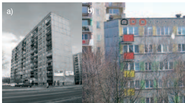
Rys. 2. Otwory w stropodachach wentylowanych budynków z wielkiej płyty
