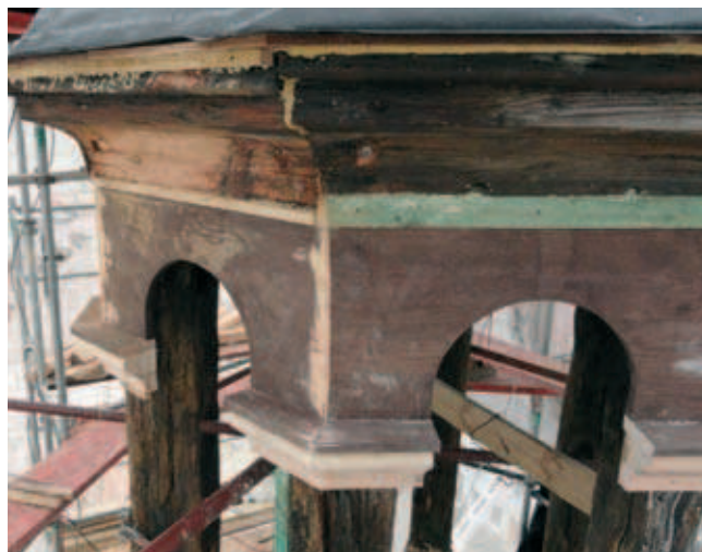
Fot. 5. Wykonane elementy maskujące konstrukcję i elementy ozdobne na poziomie „D” wieży grzyby domowe
