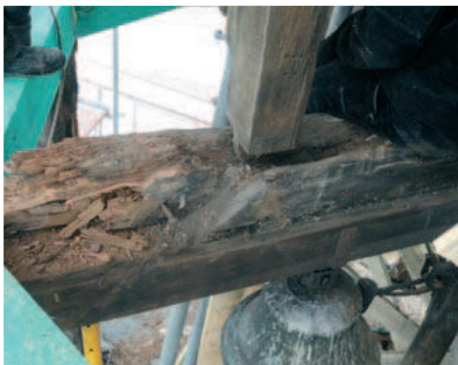
Fot. 2. Poziom „C”; gzymsy drewniane (po lewej) i słup wymienione na nowe
