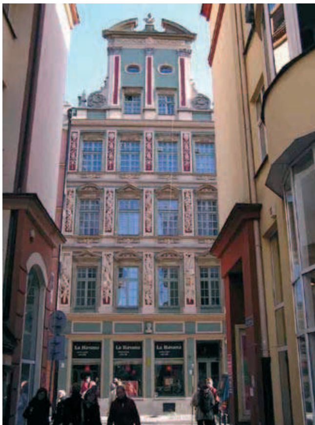
Rys. 9. Ornament gipsowy między oknami kondygnacji 3 piętra kamienicy pod Srebrnym Hełmem, stan przed remontem, fot. A. Konieczny
