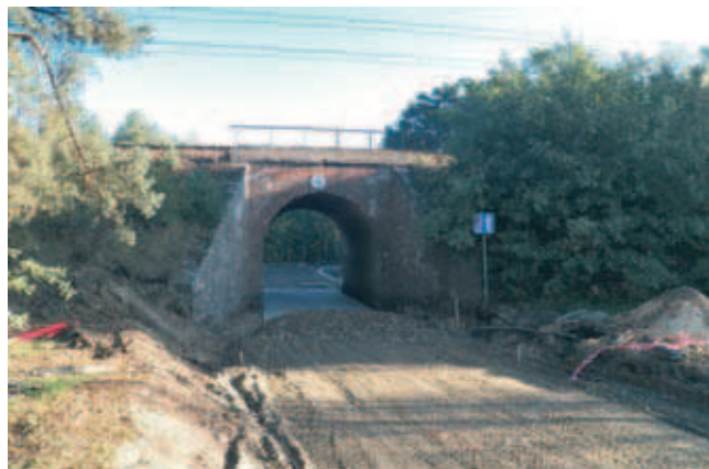
Rys. 5. Widok odcinka dojazdu do obiektu w czasie przebudowy jezdni
