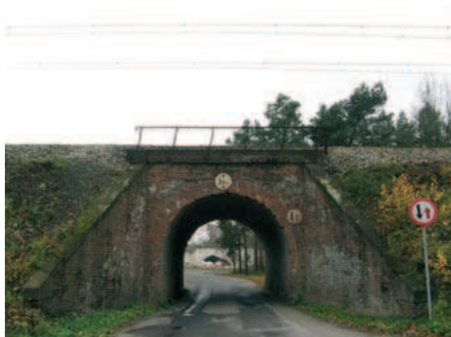
Rys. 1. Widok ogólny wiaduktu kolejowego w ciągu ulicy Foluszowej, w Zielonej Górze przed jego przebudową
