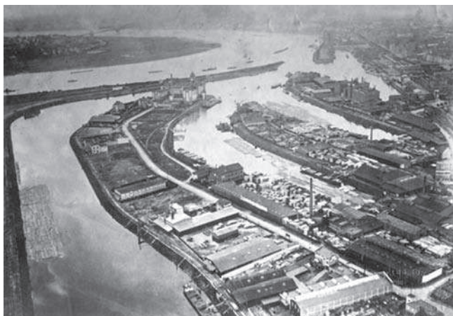
Rys. 1 Widok na baseny portowe, [5]
