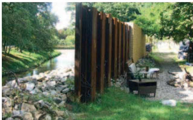
Rys. 3. Rzeka Lubsza, stalowa ścianka oporowa między budynkiem a rzeką
