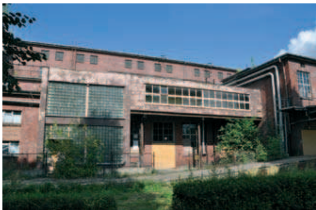
Fot. 3. Budynek produkcji folii, fragment elewacji południowej. Widok od południowego zachodu
