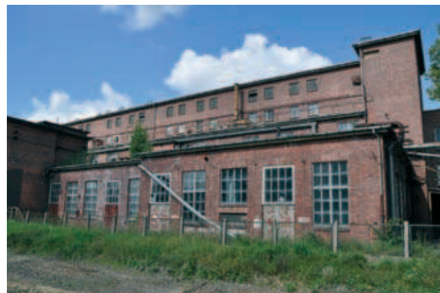
Fot. 4. Budynek produkcji folii, fragment elewacji południowej. Widok od południowego wschodu
