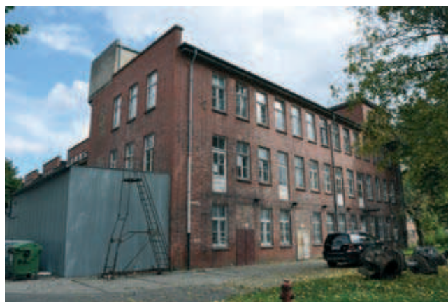
Fot. 2. Budynek produkcji folii, elewacja zachodnia. Widok od północnego zachodu
