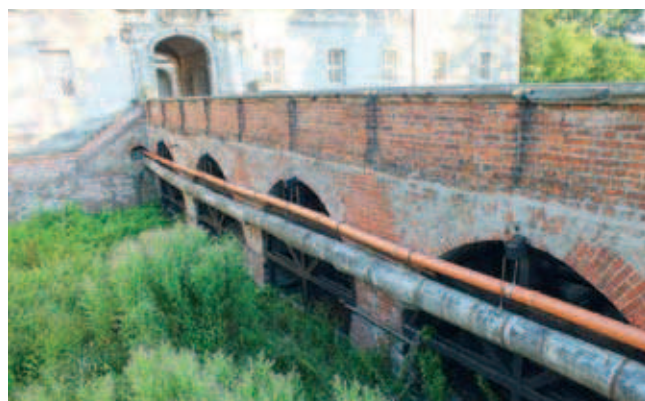
Fot. 1. Widok mostu przedniego w pałacu w Zaborze
