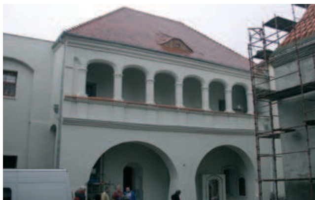
Fot. 2 Prace związane z odbudową skrzydła południowego zamku w Krośnie Odrzańskim
