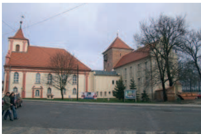
Fot. 3. Zamek i kościół pokalwiński w Sulechowie po pracach remontowych
