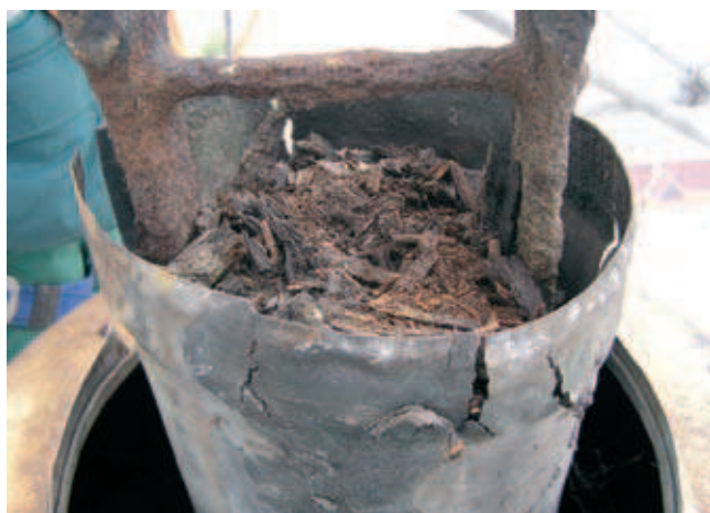
Rys. 5. Zdemontowane porażone biologicznie elementy drewniane oraz widok na słup („król”) mocujący krzyż
