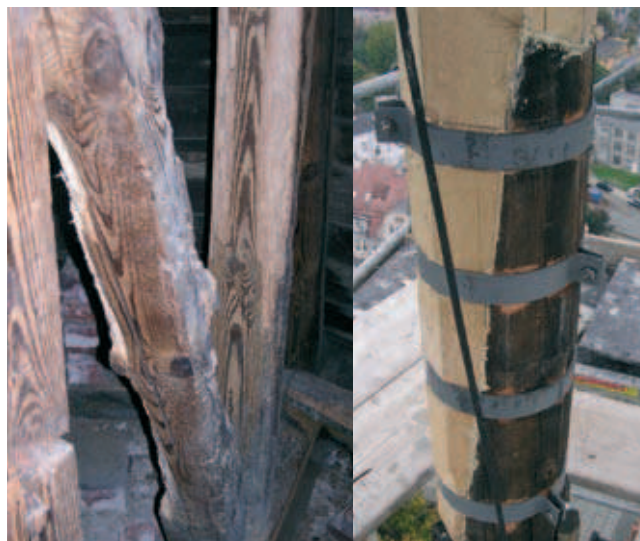
Rys. 8. Oczyszczone elementy drewniane przed wzmocnieniem; widoczne wzmocnienie nakładkami stalowymi belki głównej (z lewej) oraz wymieniony fragment słupa do mocowania krzyża – tzw. „króla” (z prawej)
