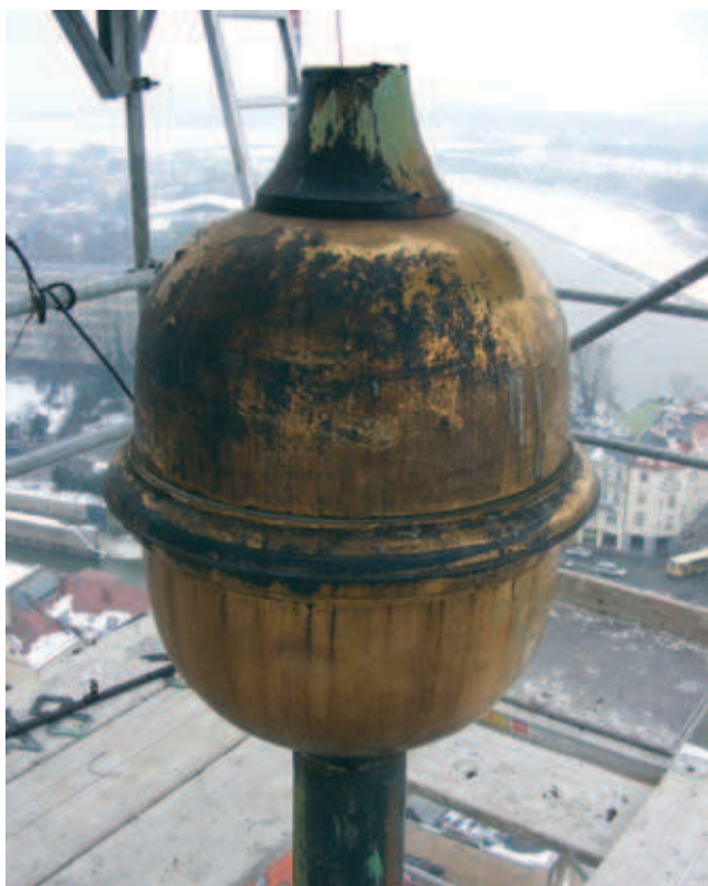
Rys. 7. Wieża północna po restauracji, a południowa w jej trakcie; złociona kula (na dole) przed konserwacją
