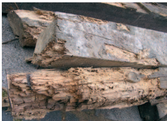
Rys. 5. Zdemontowane porażone biologicznie elementy drewniane oraz widok na słup („król”) mocujący krzyż
