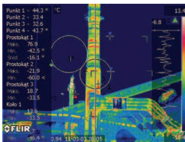
Rys. 1a. Termogram stalowego komina dwupłaszczowego z wymurówką
