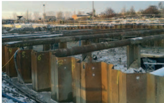
Fot. 6. Segmenty 1–8 rozparte stalowymi rurami
