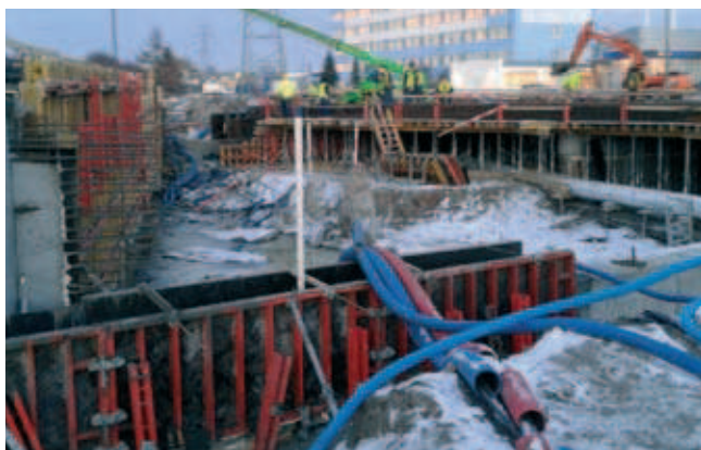
Fot. 5. Wykonywany strop segmentu 56
