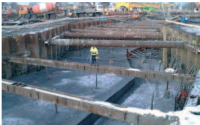
Fot. 4. Rozparcie stalowe grodziec zabezpieczających wykop tunelu dla pieszych w okolicy segmentu 55
