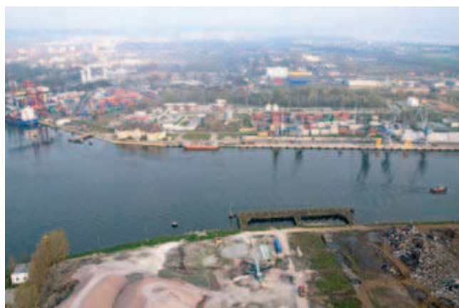
Fot. 1. Widok na Martwą Wisłę w miejscu budowanego tunelu
