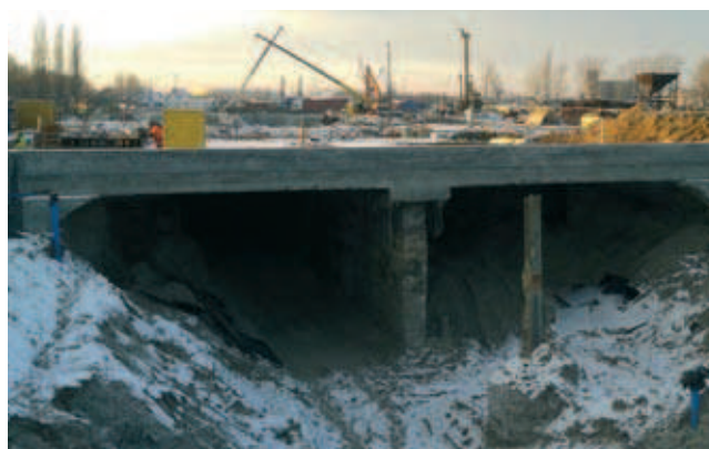
Fot. 7. Widok z boku na gotowy strop segmentu 13
