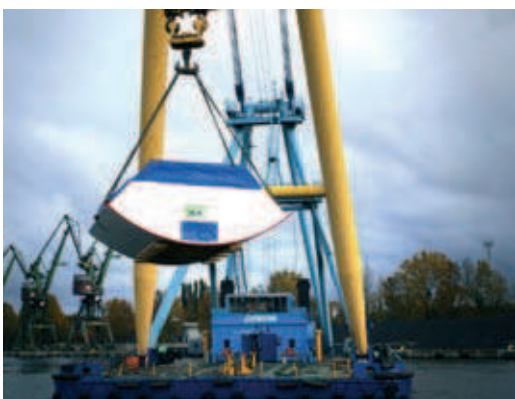
Fot. 2. Maszyna TBM: widok z przodu na tarczę, transporto- wany element i etap składania
