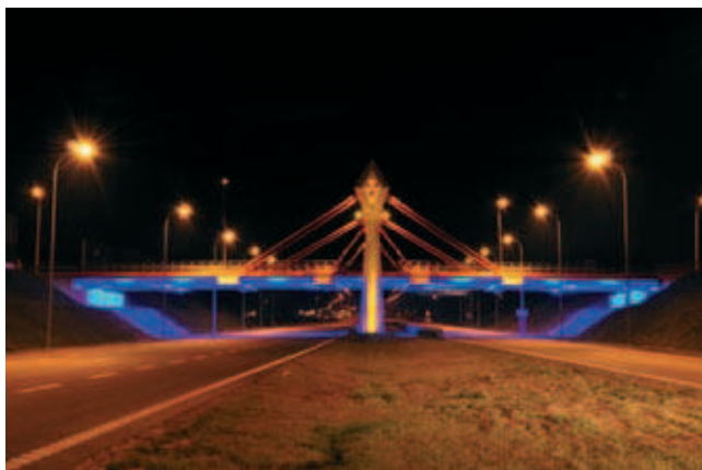
Fot. 2. Jeden z wiaduktów w ciągu Trasy W-Z nocą
