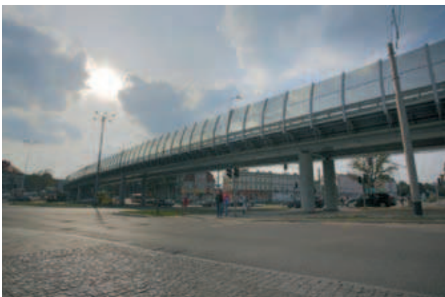
Fot. 4. Trasa Słowackiego, zadanie 2 – estakada nad Al. Grunwaldzką
