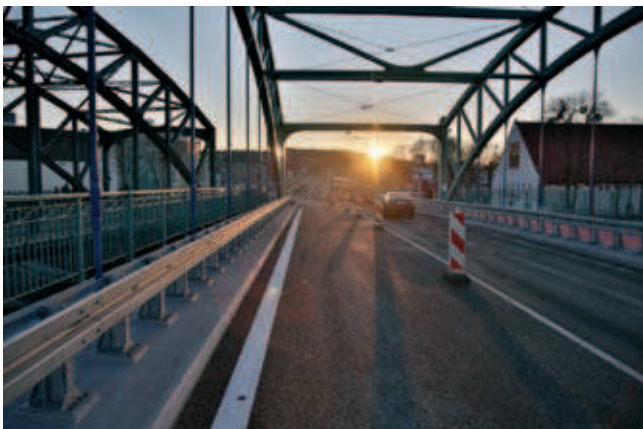
Fot. 5. Trasa Słowackiego, zadanie 2 – wiadukt nad magistralą kolejową
