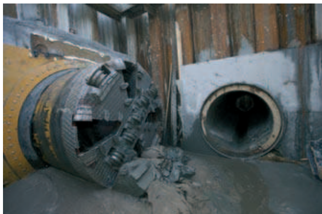
Fot. 14. Maszyna do mikrotunelingu
