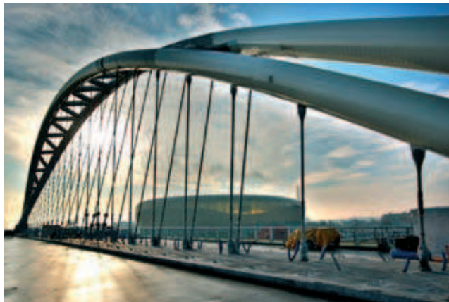
Fot. 6. Trasa Słowackiego, zadanie 3 – wiadukt nad magistralą kolejową prowadzącą do portu Gdańsk, w głębi stadion PGE Arena Gdańsk
