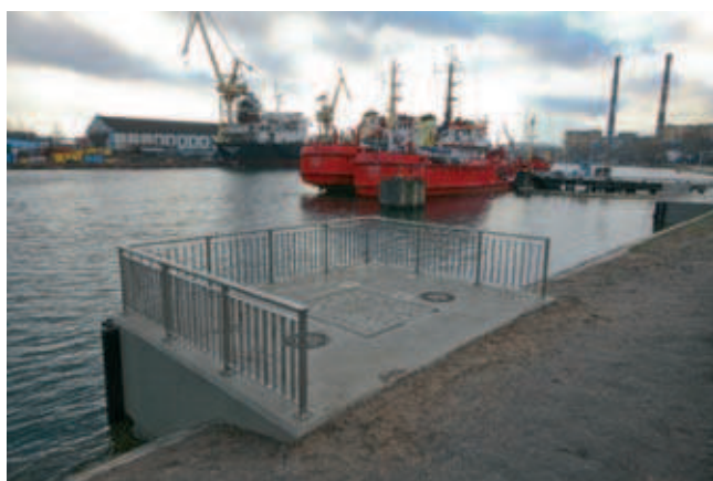
Fot. 15. Wylot kolektora do kanału portowego
