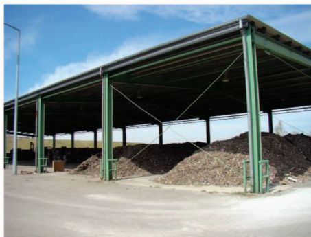
Ryc. 8. Zespół bioreaktorów Kneer-Horstman (a) oraz przyzmy stabilizatorów, z których pobrano próby do badań (b)
