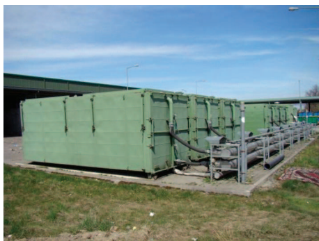
Ryc. 8. Zespół bioreaktorów Kneer-Horstman (a) oraz przyzmy stabilizatorów, z których pobrano próby do badań (b)
