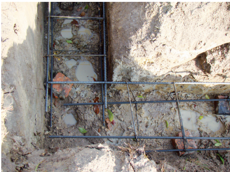
Fot. 3. Szczegół wykopu i zbrojenia ławy fundamentowej
