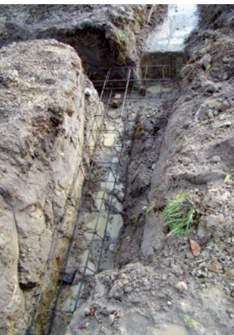
Fot. 2. Widok wykopu pod ławę fundamentową
