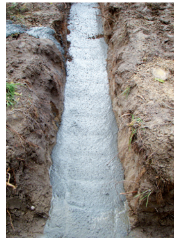
Fot. 4. Mieszanka Agilia™ Fundamenty wypełniająca wykop pod ławę fundamentową
