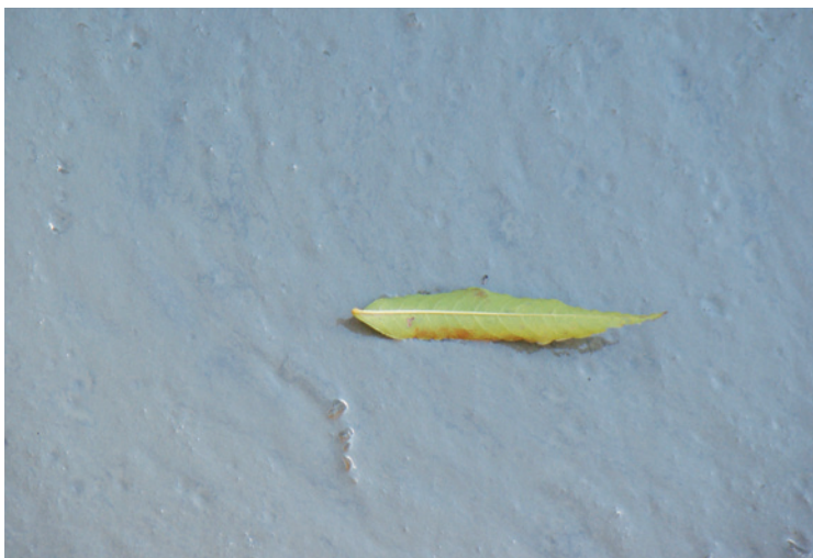
Fot. 5. Powierzchnia mieszanki betonowej Agilia™ Fundamenty po samowypoziomowaniu
