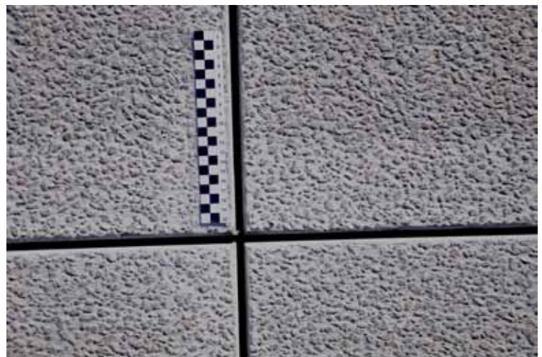
Rys. 12. Widok nawierzchni z odkrytym kruszywem
