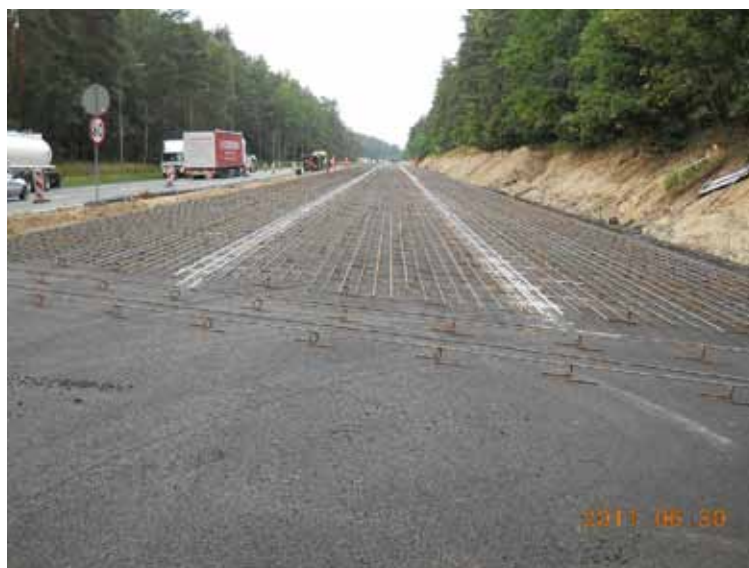
Rys. 8. Widok zbrojenia na autostradzie A2
