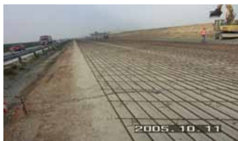
Rys. 8. Widok zbrojenia na autostradzie A2
