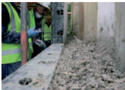
Fot. 1. Budowa ściany z konopi z dodatkiem spoiwa wapiennego [3]
