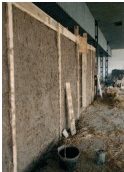
Fot. 3. Ściana z kostek słomy z nałożonym tynkiem glinianym (fot. autora)
