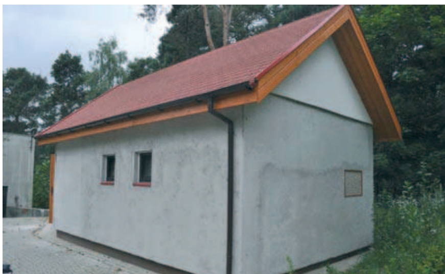
Fot. 2. Budynek eksperymentalny Instytutu Włókien Naturalnych i Roślin Zielarskich
