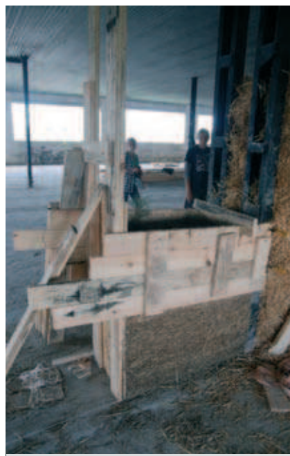
Fot. 6. Budowa ściany w technice gliny lekkiej [10]
