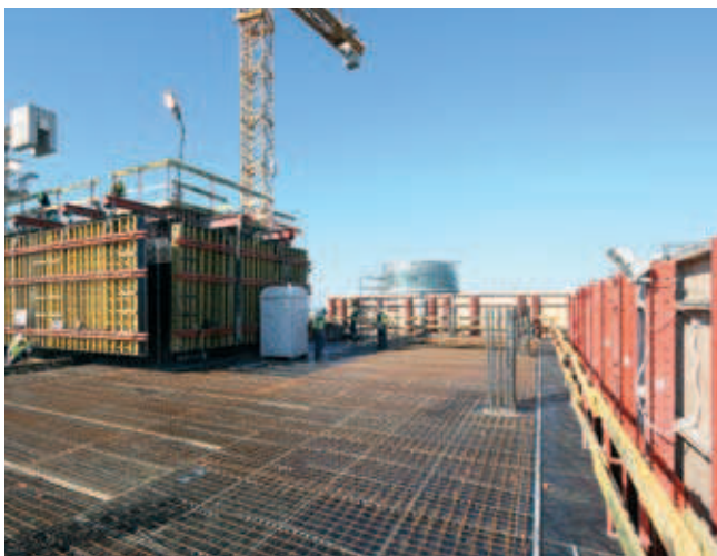
Fot. 2. Bezpieczna i efektywna praca na dużych wysokościach dzięki pomostom osłonowym RCS-P. Budowa „Cosmopolitan Twarda 2/4”
