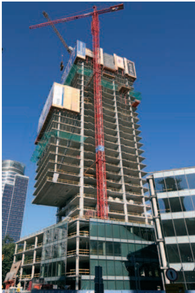
Fot. 1. Budowa „Cosmopolitan Twarda 2/4” w Warszawie
