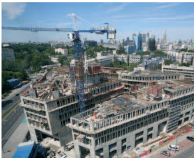
Fot. 4. Budowa „Plac Unii” w Warszawie
