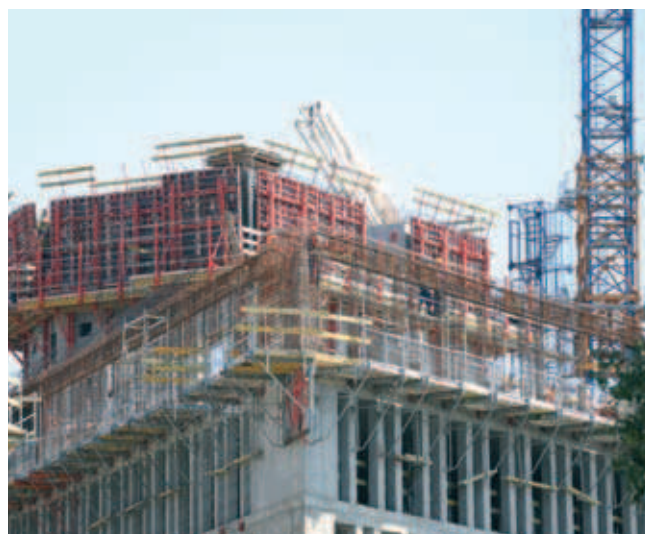
Fot. 3. Budowa „Plac Unii” w Warszawie
