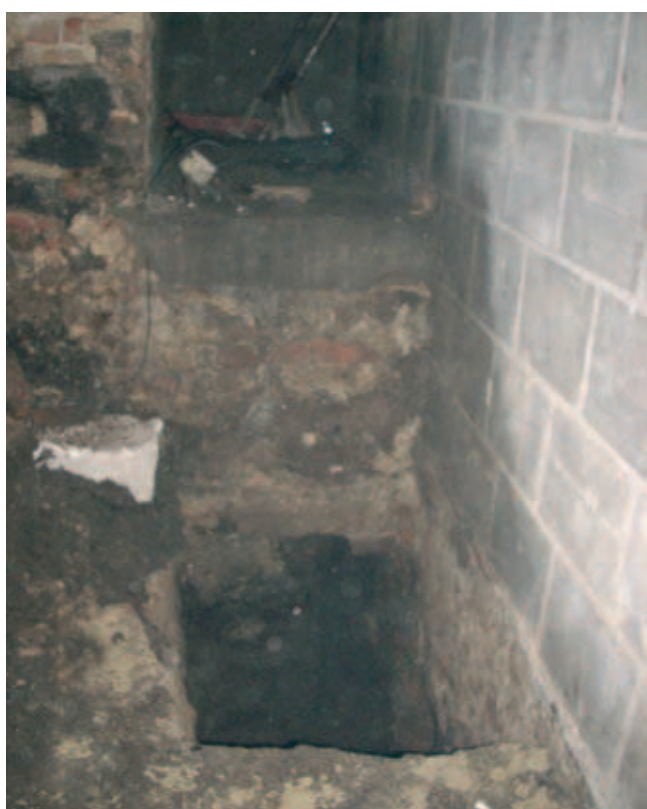
Fot. 3. Posadowienie ścian dobudowanej klatki schodowej na starym fundamencie
