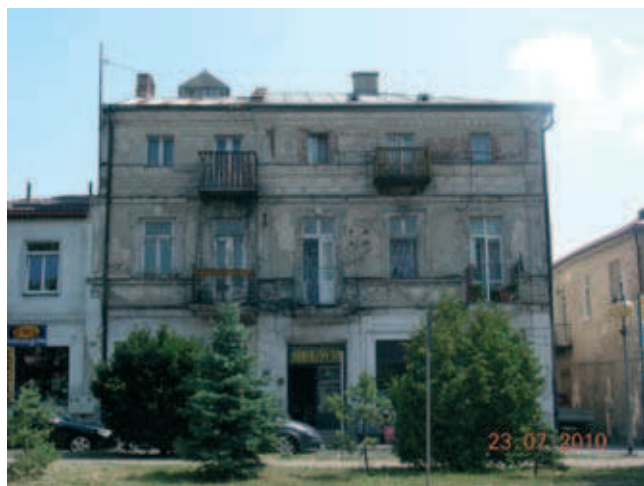
Fot. 1. Widok ogólny budynku
