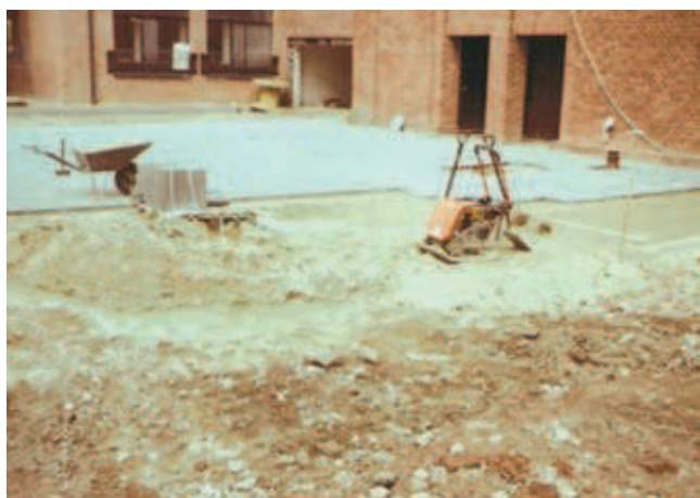
Rys. 8. Podbudowy dróg i placów z materiału z odzysku – Lofty – opracowanie własne
