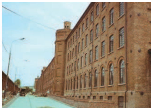
Rys. 9. Drogi i place na podbudowie z recyklingu – Lofty – opracowanie własne
