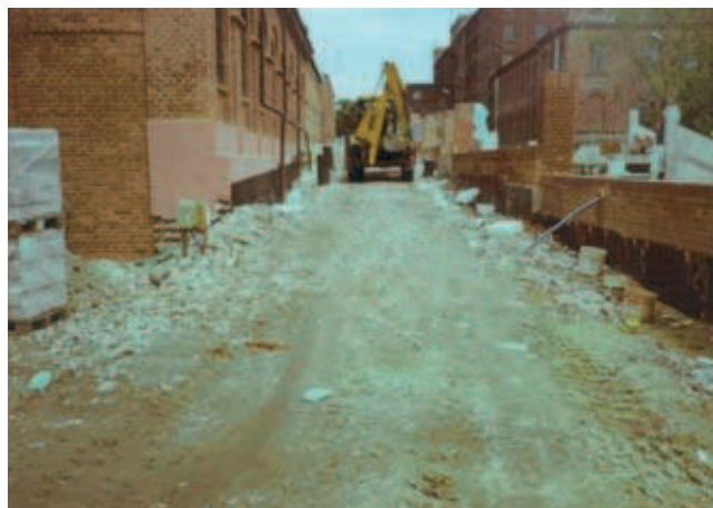
Rys. 7. Miejsce wbudowania materiału z odzysku – opracowanie własne
