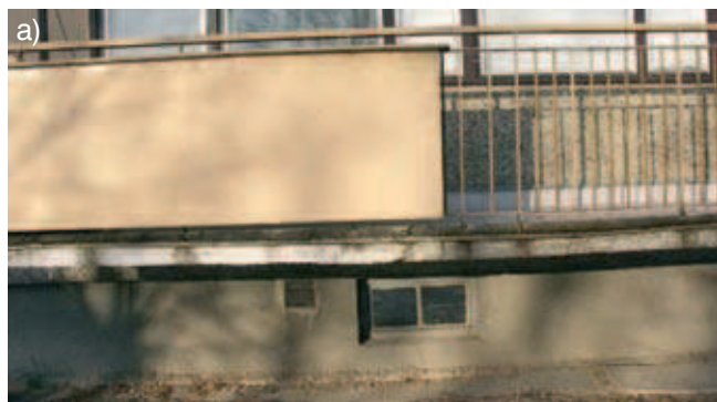
Rys. 5. Przykładowe uszkodzenia elementów konstrukcyjnych balkonów: a) ugięcie płyty balkonowej, b) destrukcja betonowej płyty; widoczne skorodowane zbrojenie
