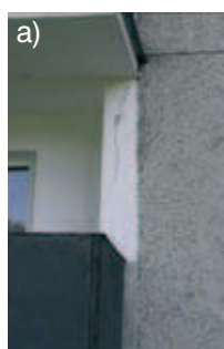
Rys. 9. Schemat typowego złącza ZWO-W-ZWL oraz przykłady uszkodzeń: a) badania autora, b) wg badań omówionych w pracy [1]
