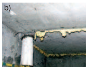
Rys. 15. Schemat typowego złącza S-S oraz przykłady zaobserwowanych uszkodzeń: a) niedostateczne umonolitycznienie złącza płyt, b) próby naprawy niedostatecznie umonolitycznionego złącza piwnicznych płyt stropowych, c) uszkodzenia piwnicznej płyty kanałowej S; widoczne wykruszenia betonu na powierzchni płyty
