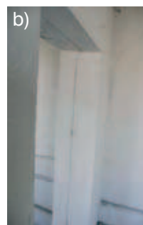
Rys. 8. Schemat typowego złącza ZWO-W-W-ZWO oraz przykłady zaobserwowanych uszkodzeń: a) uszkodzenie w złączu ZWO-W, b) brak prawidłowego wykończenia złącza dylatacyjnego w przejściu pomiędzy segmentami
