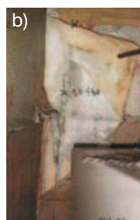
Rys. 9. Schemat typowego złącza ZWO-W-ZWL oraz przykłady uszkodzeń: a) badania autora, b) wg badań omówionych w pracy [1]
