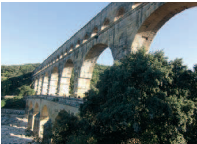
Rys. 3. Pont du Gard (Francja) [autor]
