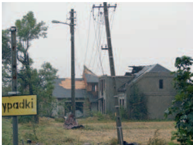
Fot. 3. Zniszczenia po wichurze w 2008 roku w województwie łódzkim
