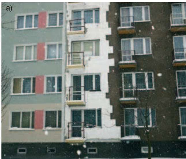
Rys. 9. a) Elewacja termomodernizowanego budynku, w tym docieplenie balkonów, b) termogram i wykres analizy rozkładu temperatury na powierzchni muru przed i po ociepleniu
