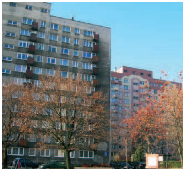
Rys. 13. Na pierwszym planie budynek wielopłytowy przed termomodernizacją, w głębi budynek po termomodernizacji, osiedle Tysiąclecia, źródło – archiwum zarządcy
