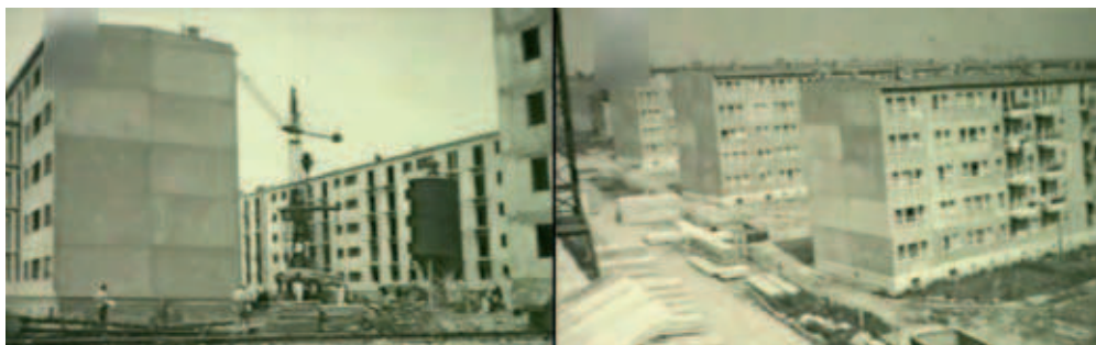
Rys. 2. Fotografie z prac budowlanych, lata 60. XX wieku, źródło – archiwum zarządcy
