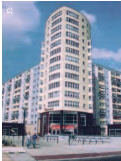
Rys. 3. Przykłady modernizacji budynków wielkopłytyowych: a) wykonanie otworu w stropie dla wbudowania schodów kręconych do mieszkania dwupoziomowego [2], b) planowana nadbudowa budynku w systemie WBS 70/5 [2], c) wypełnienie luki między dwoma budynkami WBS 70 w Berlinie [2], d) docieplenie ścian 11-kondygnacyjnego budynku w Katowicach
