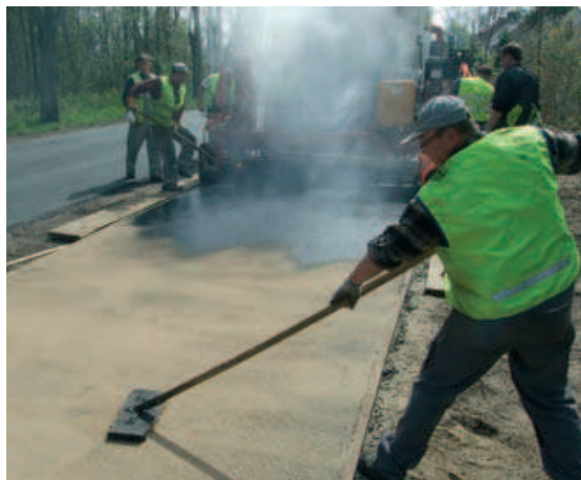
Rys. 5. Wykonanie warstwy asfaltu twardolanego: a) mechaniczna układarka przygotowana do pracy; b) układanie i uszorstnianie powierzchni
