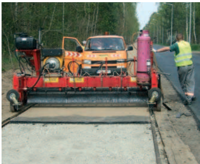
Rys. 5. Wykonanie warstwy asfaltu twardolanego: a) mechaniczna układarka przygotowana do pracy; b) układanie i uszorstnianie powierzchni
