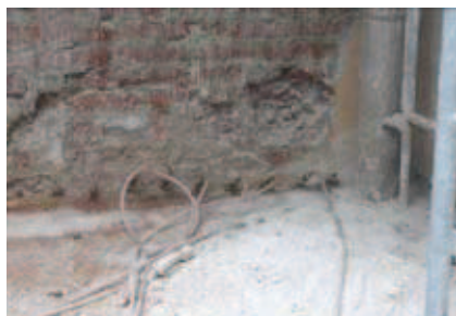
Rys. 4. Iniekcja preparatu krzemianującego i hydrofobizującego w konstrukcję murową
