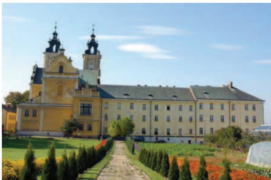
Rys. 1. Widok Kościoła i Zespołu Klasztornego Ojców Jezuitów w Starej Wsi – stan przed renowacją
