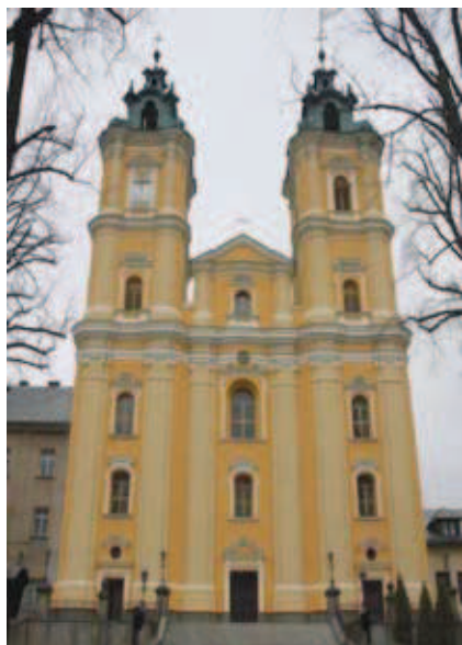
Rys. 14. Wieże kościoła Ojców Jezuitów w Starej Wsi po renowacji z wykorzystaniem systemu MAPE-ANTIQUE
