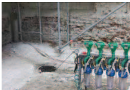
Rys. 4. Iniekcja preparatu krzemianującego i hydrofobizującego w konstrukcję murową
