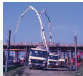
Rys. 8. Zdalnie sterowane ramiona pomp do betonu. Zdjęcie z autostradowej obwodnicy Wrocławia
