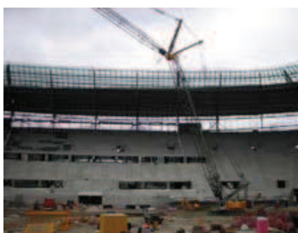
Rys. 9. Zdalnie sterowany i samowznoszący żuraw. Zdjęcie z budowy nowego stadionu we Wrocławiu. Więcej o rozwoju żurawi – [6]
