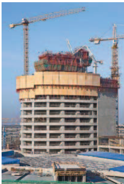
Rys. 10. Samowznoszące deskowania PERI. Zdjęcie z budowy Sky Tower we Wrocławiu
