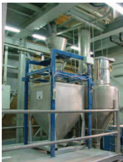
Rys. 4. Przestrzeń pod analizowanym stropem. Stan pierwotny
