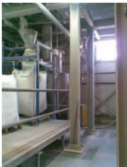
Rys. 5. Dodatkowe dwa słupy wzmacniające strop
