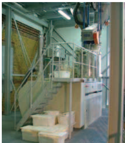
Rys. 2. Zespół mieszalników na stropie stalowym
