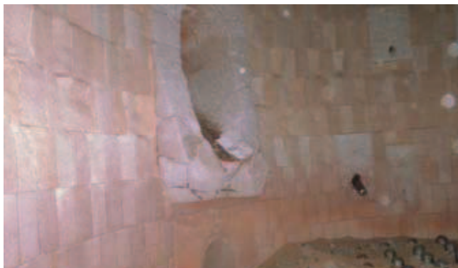
Rys. 1. Schemat części dennej oddzielnicy popiołu wraz ze zdjęciem uszkodzonej wymurówki
