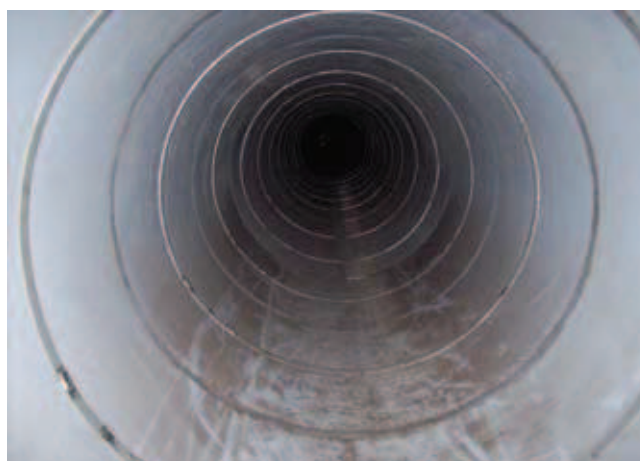
Rys. 4. Kolektor wody chłodzącej – system KANREM [8]
