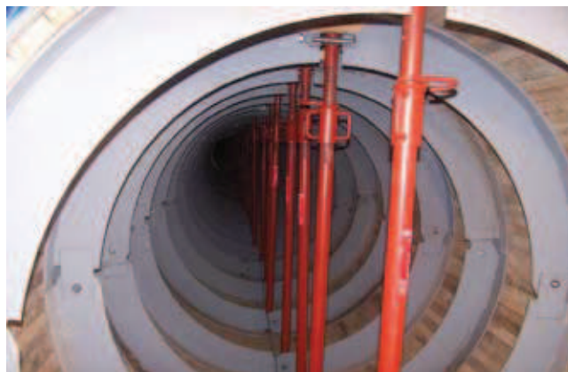
Rys. 3. Szalunek wewnętrzny w systemie MAXI-LINING [8]
