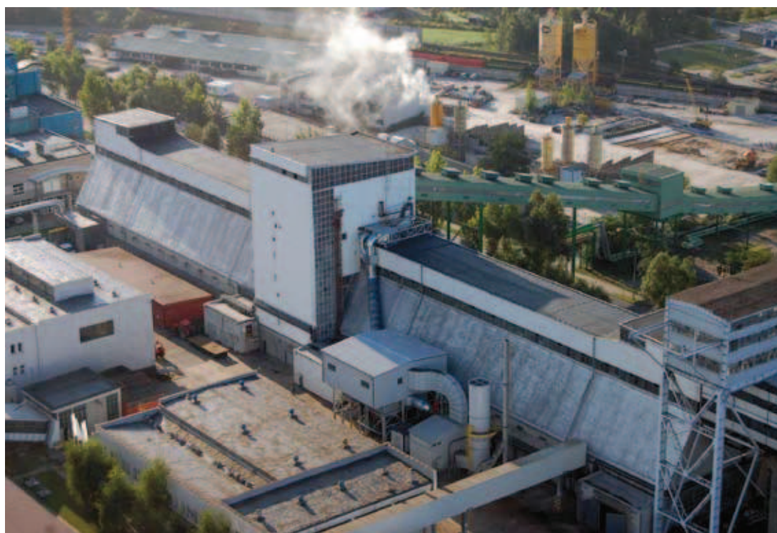
Rys. 1. Widok ogólny zasobnika węglowego
